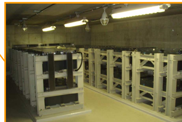
蓄電池設置の設置イメージ図
