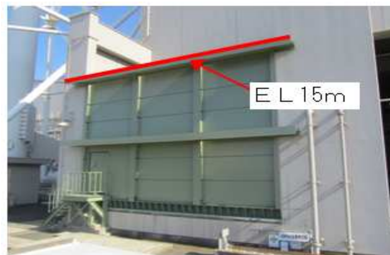
2号機変圧器エリアに設置した防水壁
