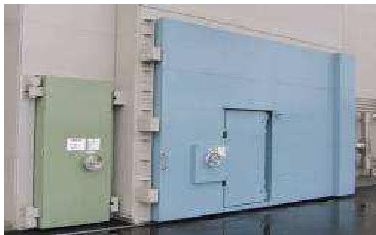
▲ 3号機建物外壁に設置した水密扉
