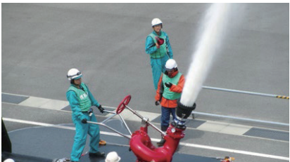
発電所外への放射性物質の拡散を抑制するため、放水砲および大型送水ポンプ車を配備
