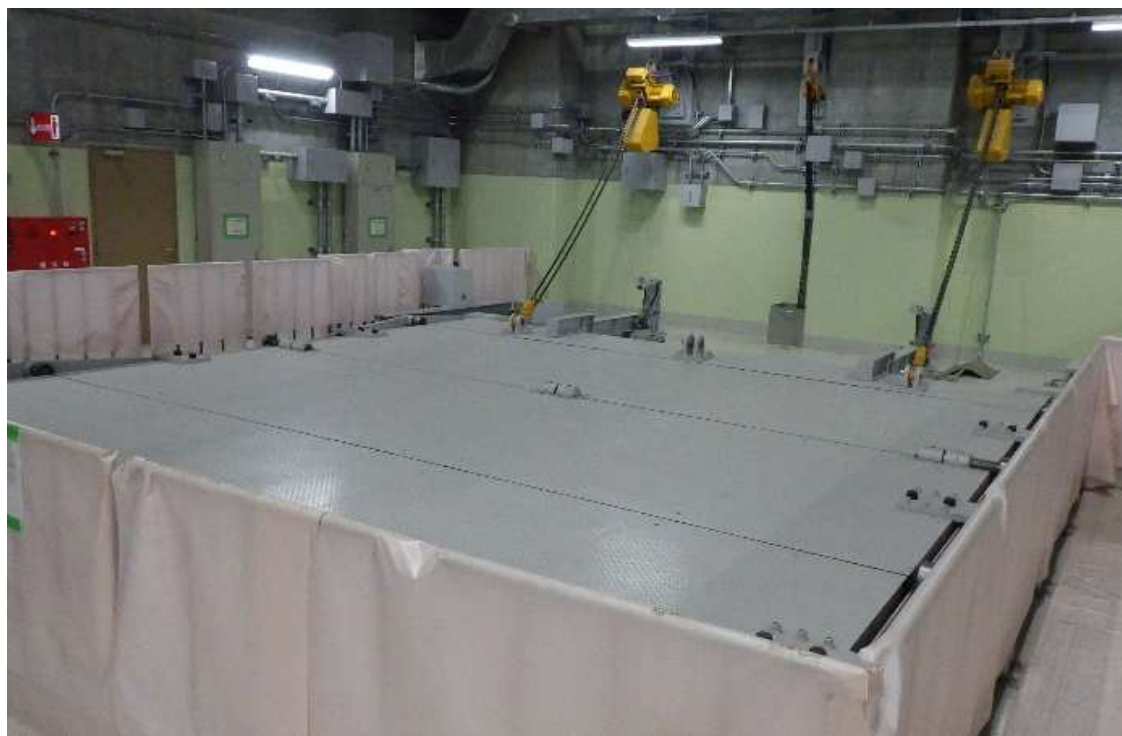
大物搬入口ハッチ外観
