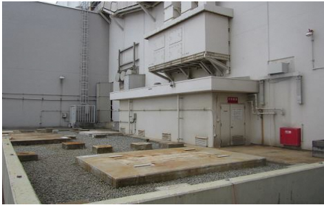
撤去作業後の状況
