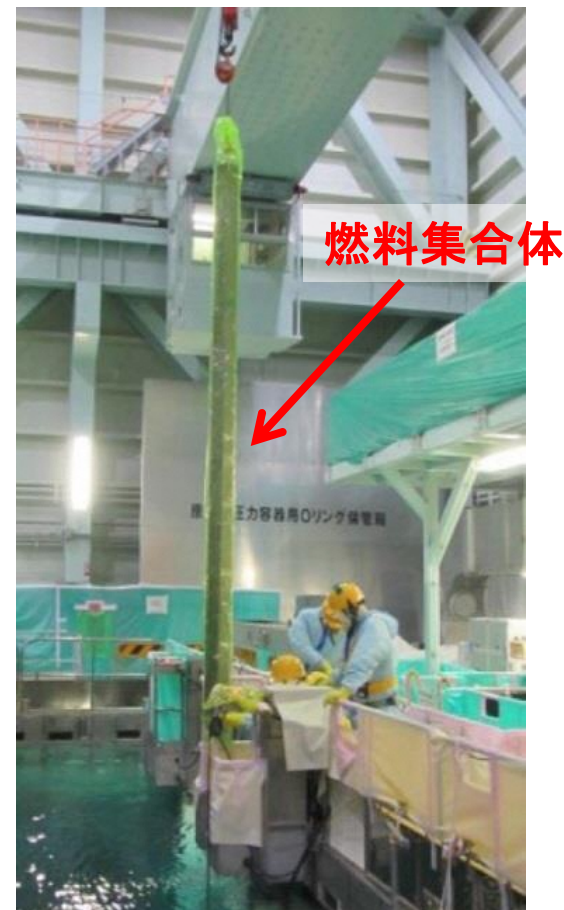
新燃料の引き上げ状況
