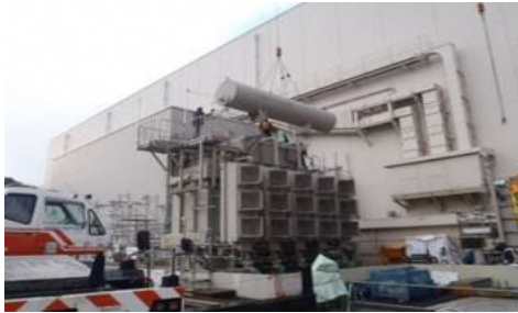
撤去作業の状況
