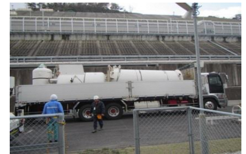
解体物の移送
