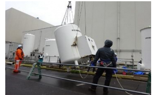
撤去作業の状況
