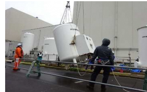
撤去作業の状況
