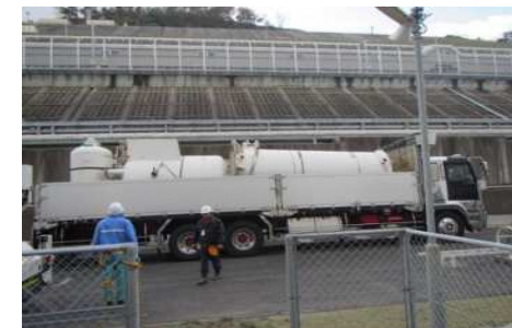
解体物の移送
