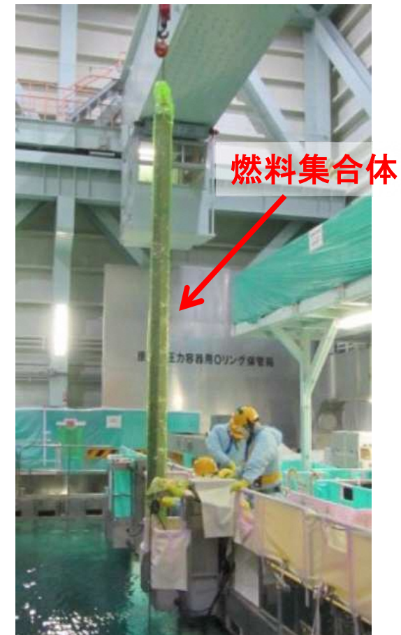
新燃料の引き上げ状況
