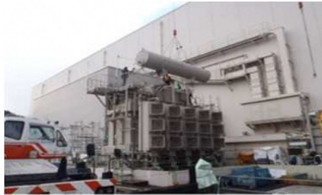
撤去作業の状況
