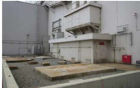
撤去作業後の状況
