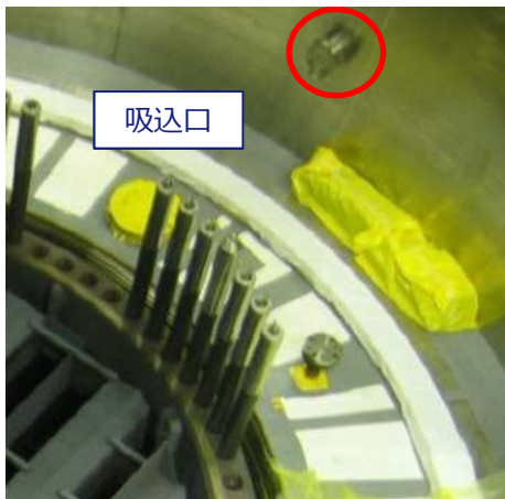
対策①：吸込口閉止（溶接構造）
