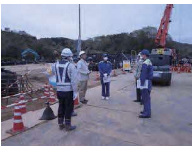
除染廃棄物仮置場での説明
