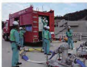
大量送水車を用いた送水訓練
