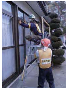
住宅除染作業の状況
