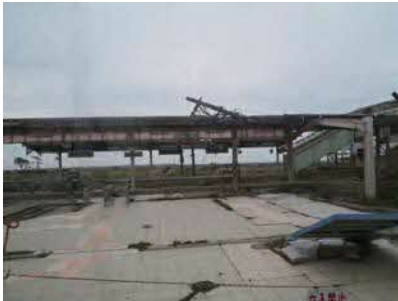
富岡駅周辺津波被害状況
