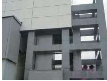
構内バスから見る4号機
