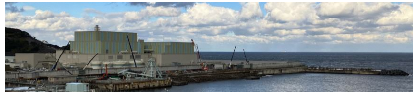
敷地東側からの全景
