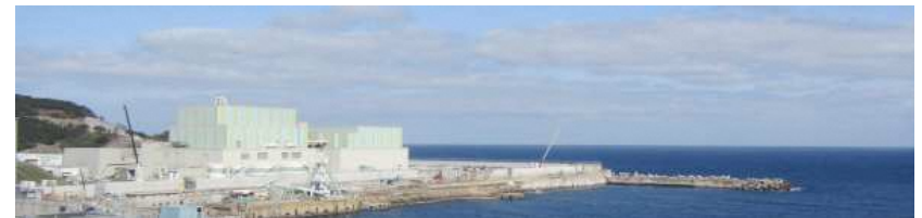
敷地東側からの全景
