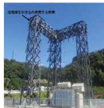
岩盤上に直接鉄構を設置し高い耐震性を有する緊急用開閉所
