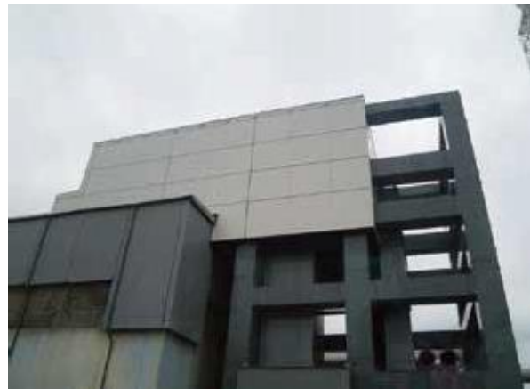
構内バスから見る4号機
