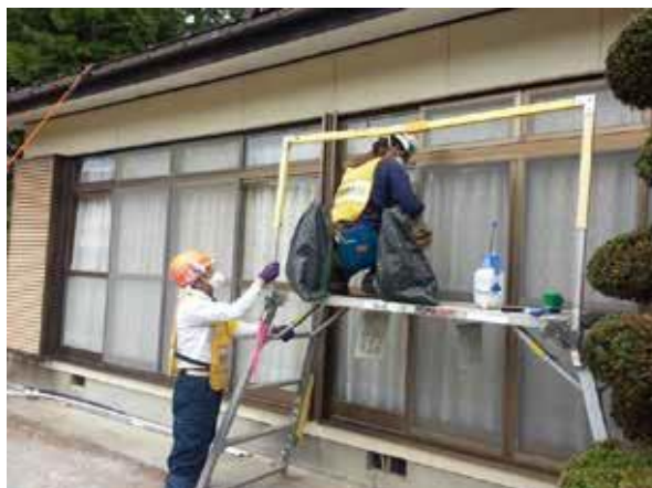
住宅除染作業の状況
