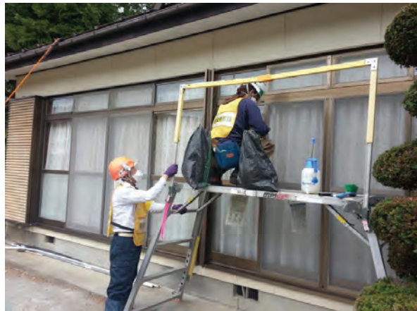
住宅除染作業の状況
