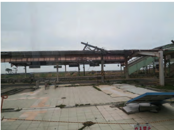
富岡駅周辺の津波被害状況
