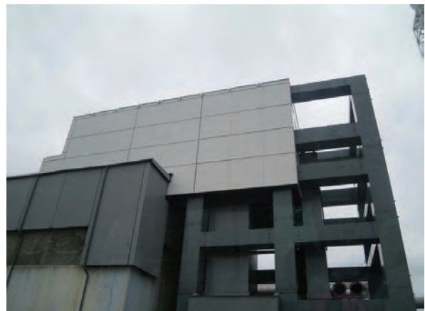
構内バスから見る 4号機
