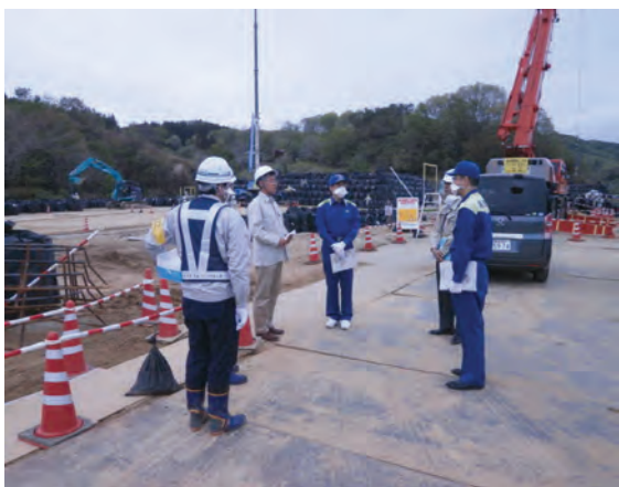
除染廃棄物仮置場での説明
