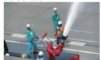
放水砲等の配備
