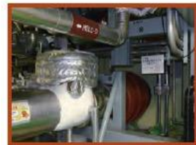
耐震補強工事前
