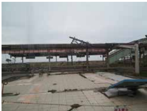
富岡駅周辺津波被害状況
