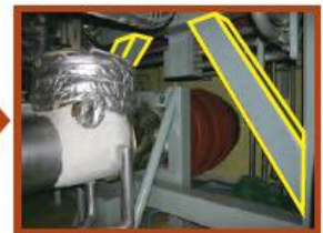
耐震補強工事後
