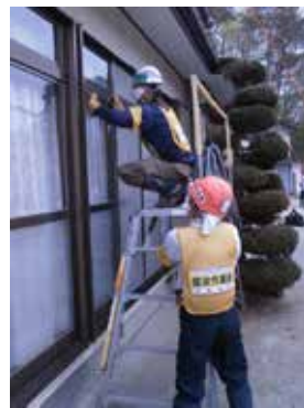
住宅除染作業の状況
