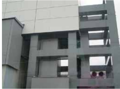
構内バスから見る4号機
