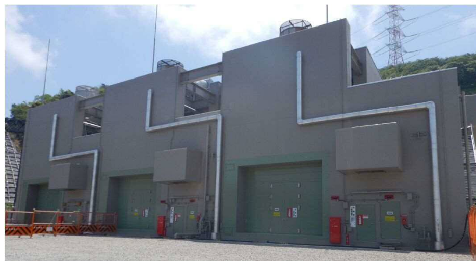
建物工事状況(平成30年5月14日撮影)
