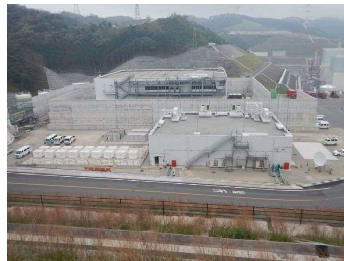
工事状況(平成30年4月23日撮影)
