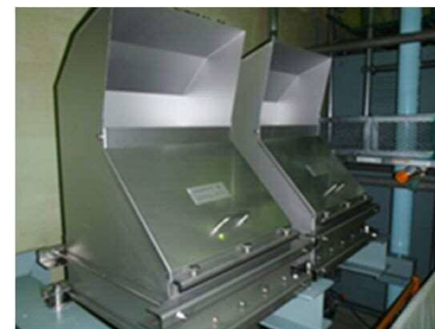
■ : 静的触媒式水素処理装置
