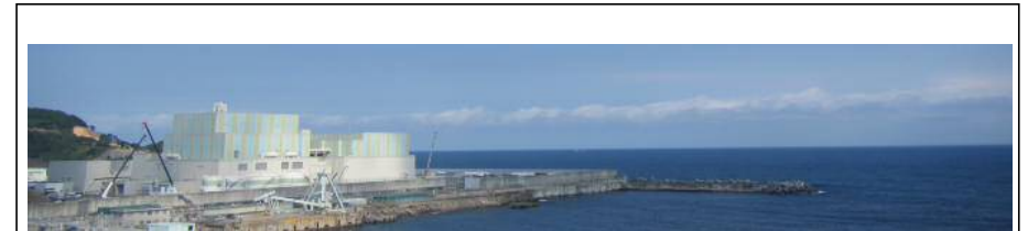
敷地東側からの全景
