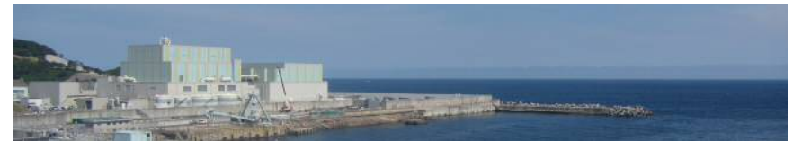
敷地東側からの全景
