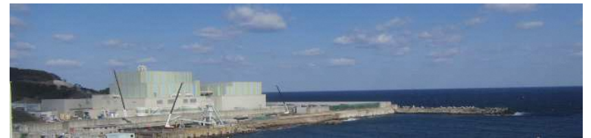
敷地東側からの全景
