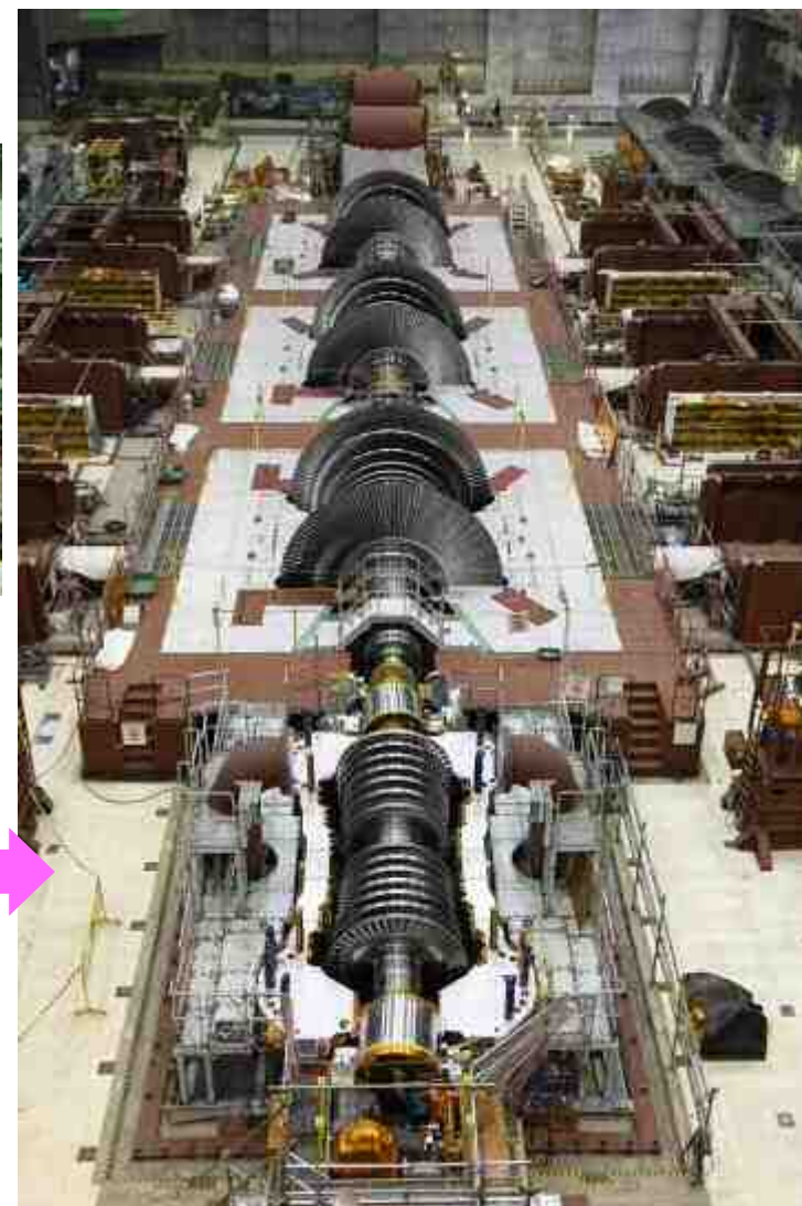
ロータ点検架台へ着座
