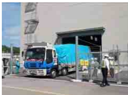
3号機エリアへ搬入
