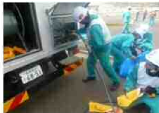
▲発電機車接続訓練
