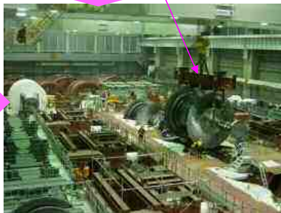
天井クレーンによる 低圧タービンロータ移動
