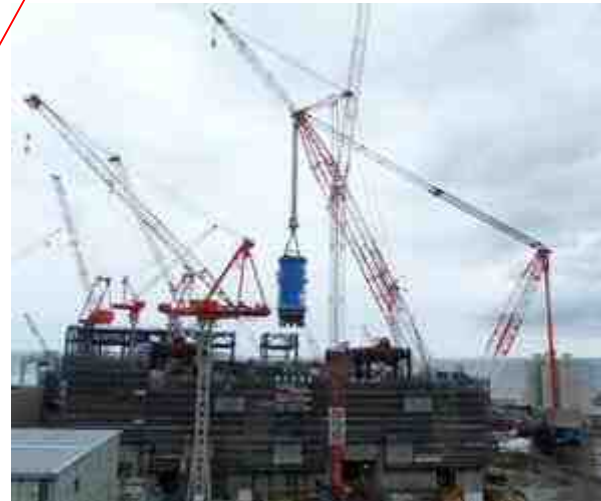
原子炉建物への吊込み
