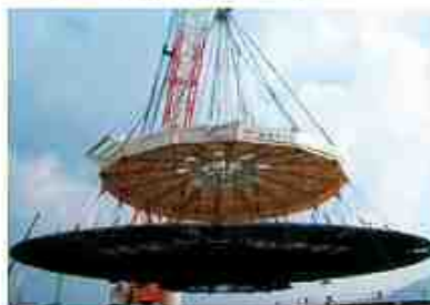
原子炉格納容器 中央マットモジュール
