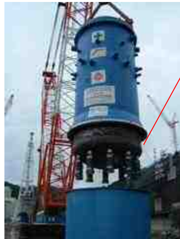
クローラークレーンによる 吊上げ
