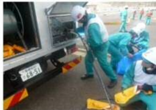
▲発電機車接続訓練
