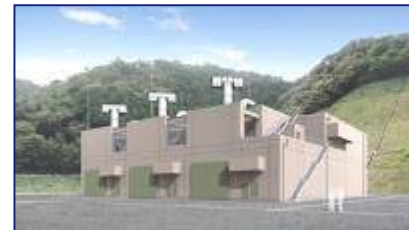
▲ガスタービン発電機
