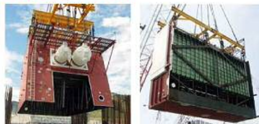
復水器胴モジュール
