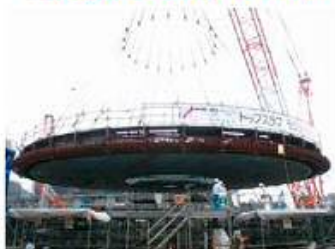
原子炉格納容器 上部(トップスラブ)モジュール
