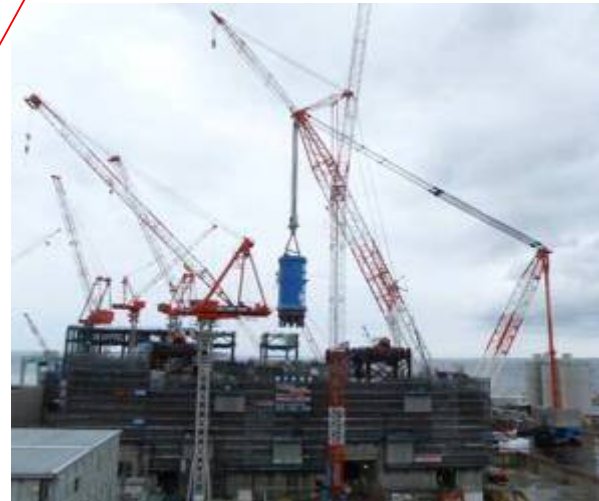
原子炉建物への吊込み
