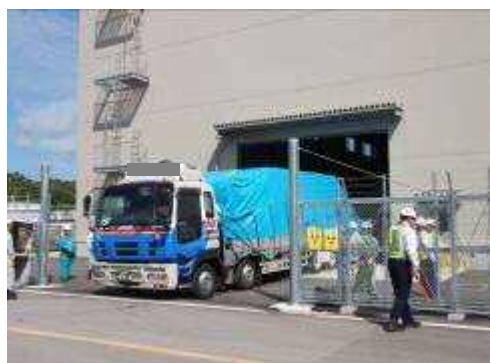
3号機エリアへ搬入
