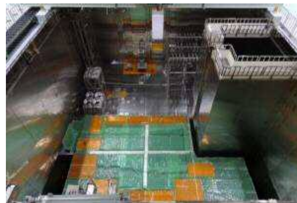
受取検査後、燃料プール他に保管
