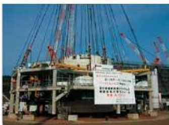
原子炉格納容器内 上部(ドライウェル)モジュール
