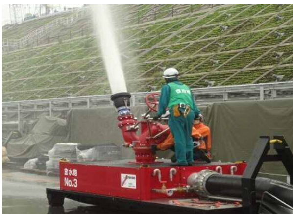
大気への放射性物質の拡散抑制(実放水試験時)
