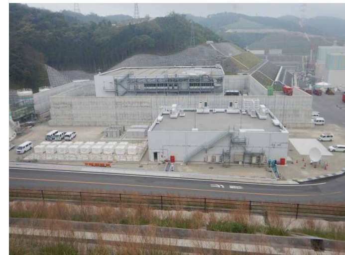
工事状況(平成30年4月23日撮影)
