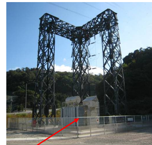
66kV受電設備 第2予備変圧器
