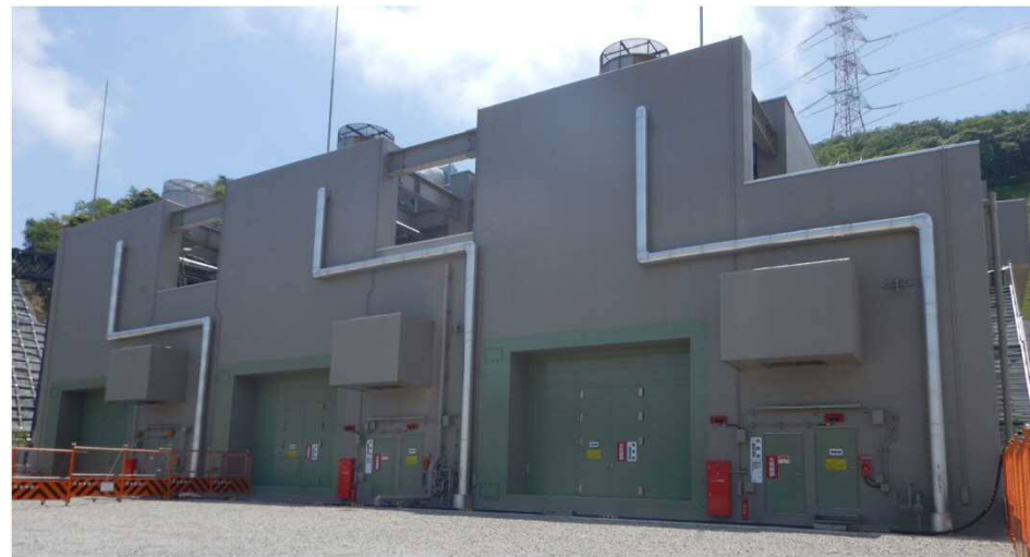
建物工事状況(平成30年5月14日撮影)
