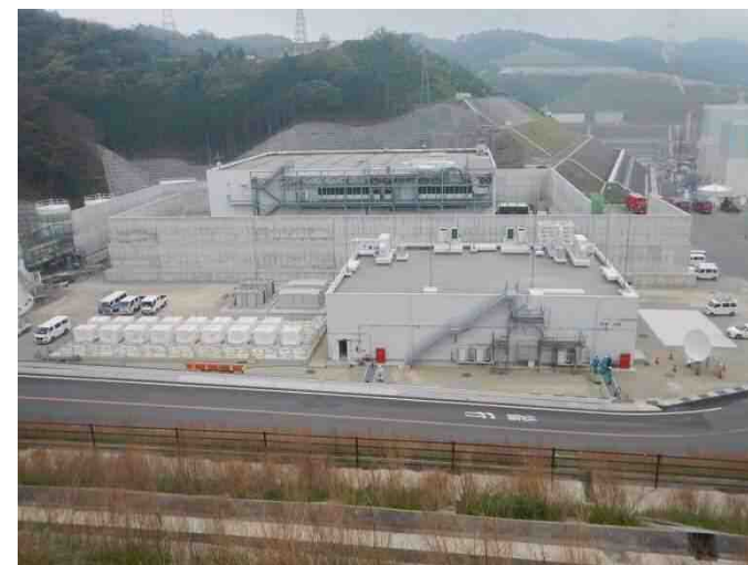
工事状況(平成30年4月23日撮影)
