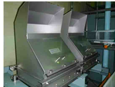
■ : 静的触媒式水素処理装置
