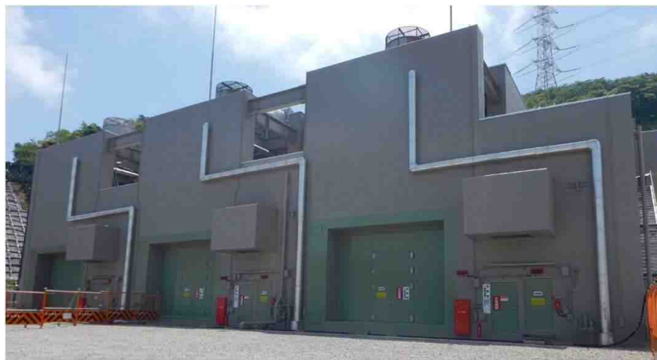
建物工事状況(平成30年5月14日撮影)
