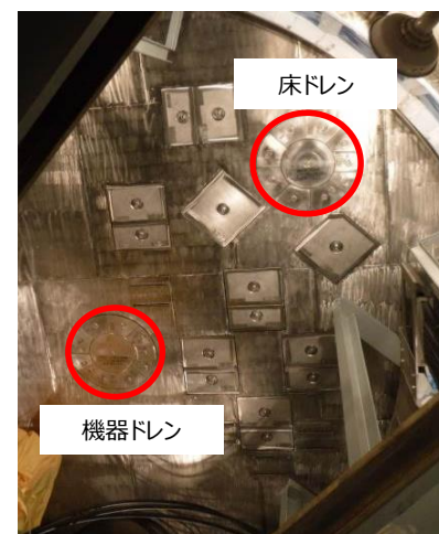
ペDESTAL内床面を上から見た写真 (コリウムシールドの外観)
