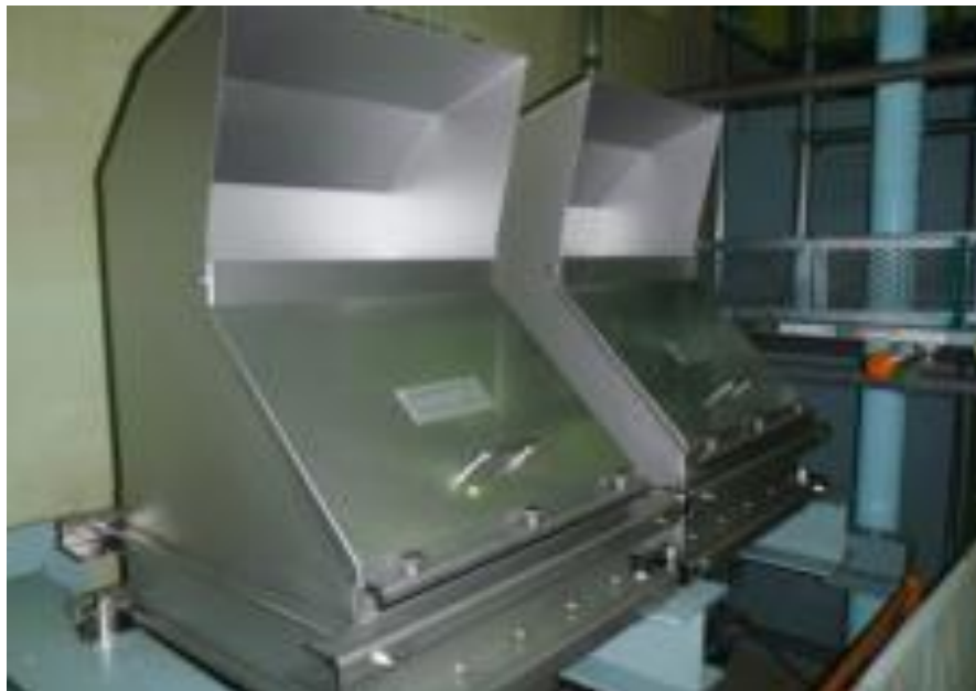
図1 静的触媒式水素処理装置（PAR）
