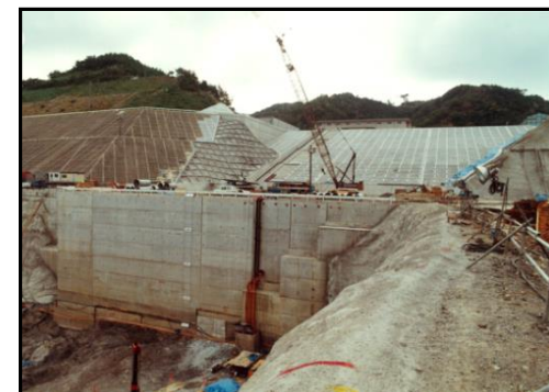
2号機 建設当時写真
