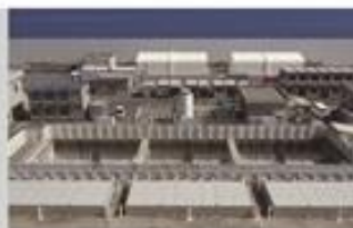
防水壁・防水蓋
