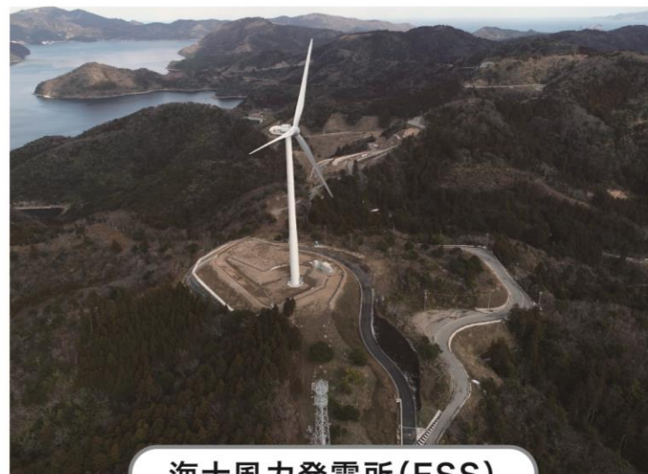
海士風力発電所(ESS)
