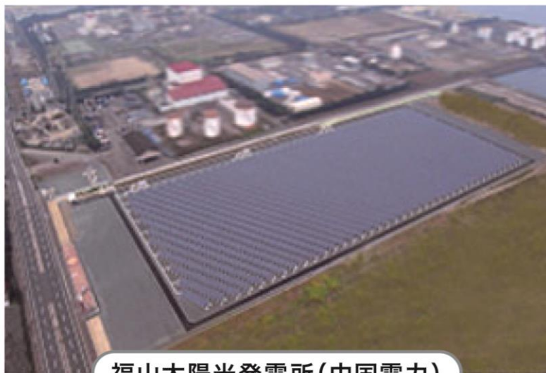
福山太陽光発電所(中国電力)
