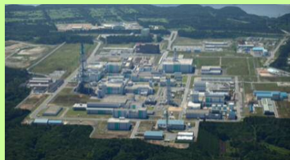
再処理工場全景※ (2018年度上期 竣工予定)
