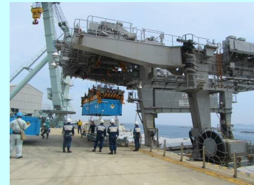
輸送船への吊り込み作業
