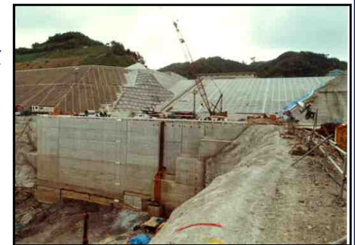
2号機 建設当時写真
