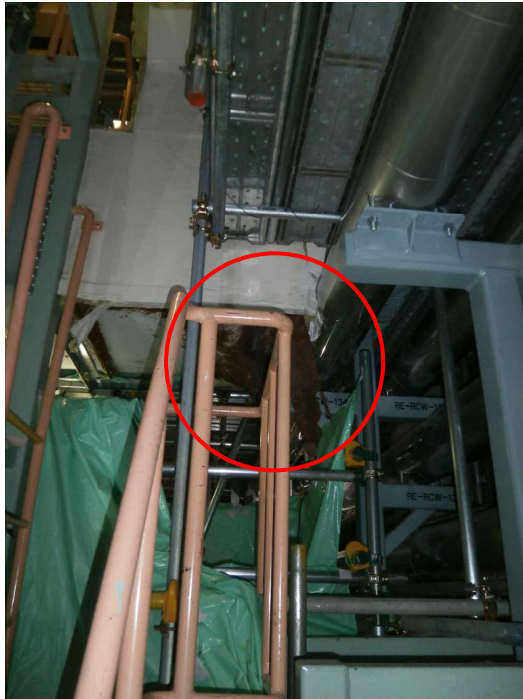
現場状況写真（12/8 鳥取県職員撮影）
