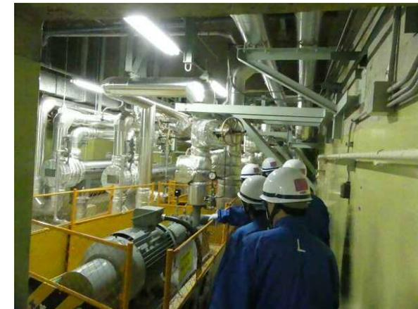
(写真2)燃料プール冷却水ポンプの維持管理状況確認
