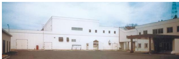
ウラン濃縮原型プラント 主棟(正面)と技術管理棟(右)
