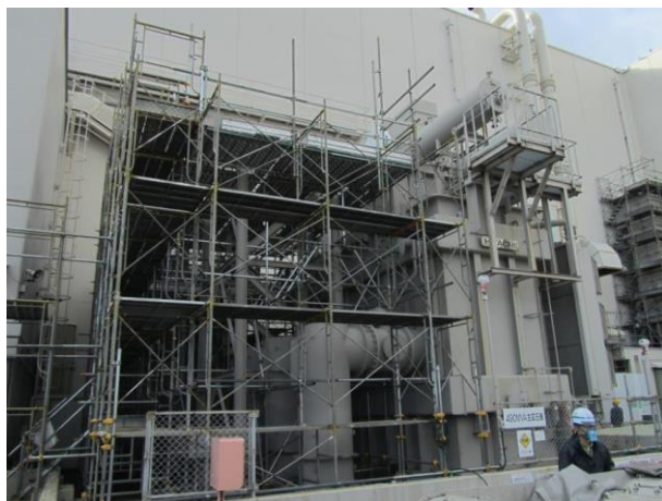
放射線管理区域外にある役目を終えた設備の解体撤去 (主変圧器等の撤去【実施中】)
