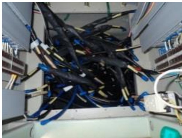
放射線管理区域外にある役目を終えた設備の解体撤去 (中央制御室床下貫通ケーブルの撤去【実施中】)
