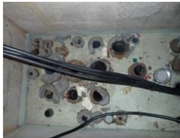
放射線管理区域外にある役目を終えた設備の解体撤去 (中央制御室床下貫通ケーブルの撤去【実施中】)
