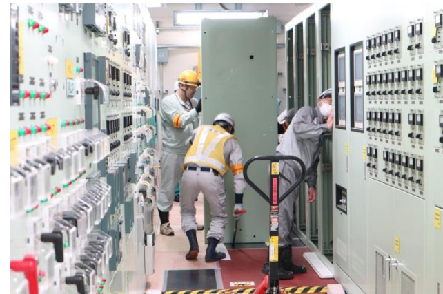
放射線管理区域外にある役目を終えた設備の解体撤去 (中央制御室制御盤の撤去)
