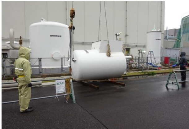
放射線管理区域外にある役目を終えた設備の解体撤去 (タンクの吊り上げ)
