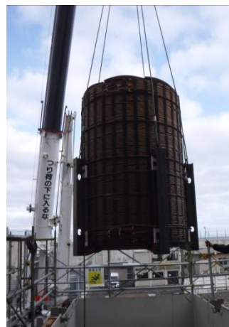
放射線管理区域外にある役目を終えた設備の解体撤去 (主変圧器等の撤去【実施中】)
