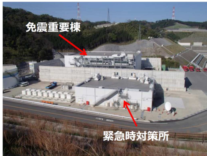
図5-26 緊急時対策所と免震重要棟
