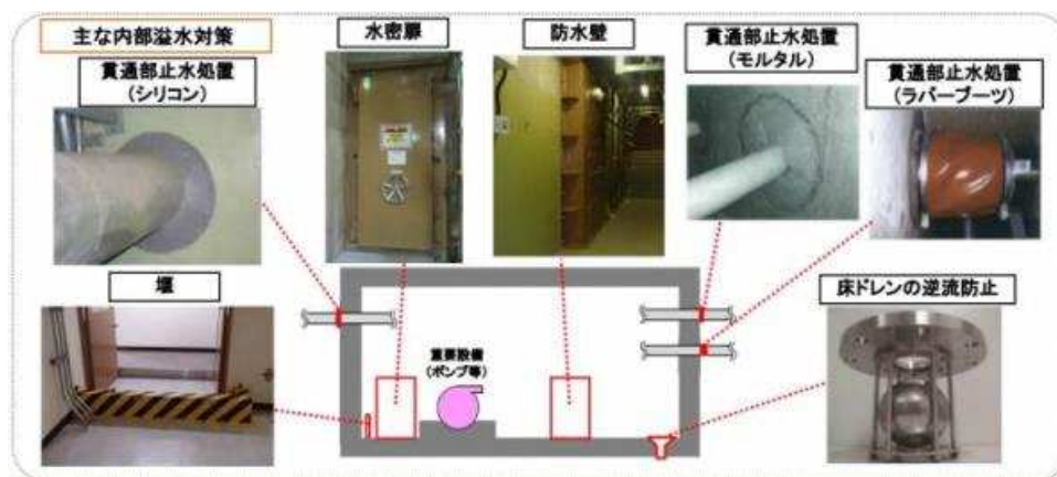
図5-15 溢水防護対策の例
