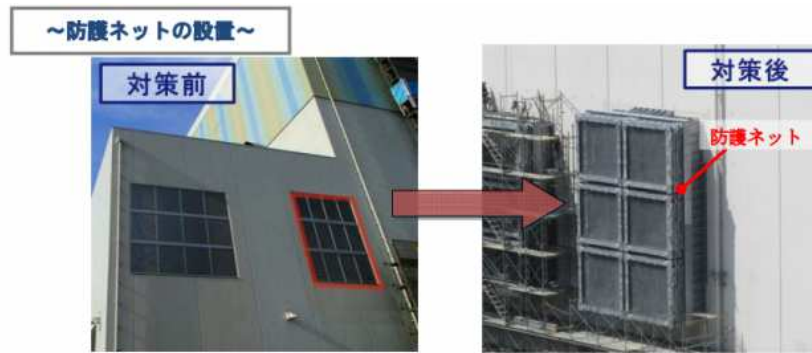
図5-1-1 飛来物への対策（竜巻防護ネット）
