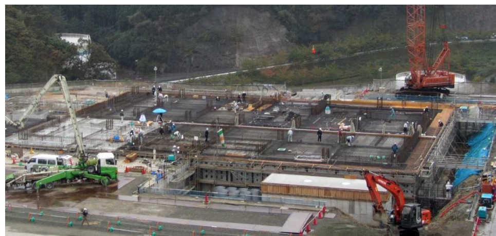
基礎工事の様子 (平成25年10月現在)
