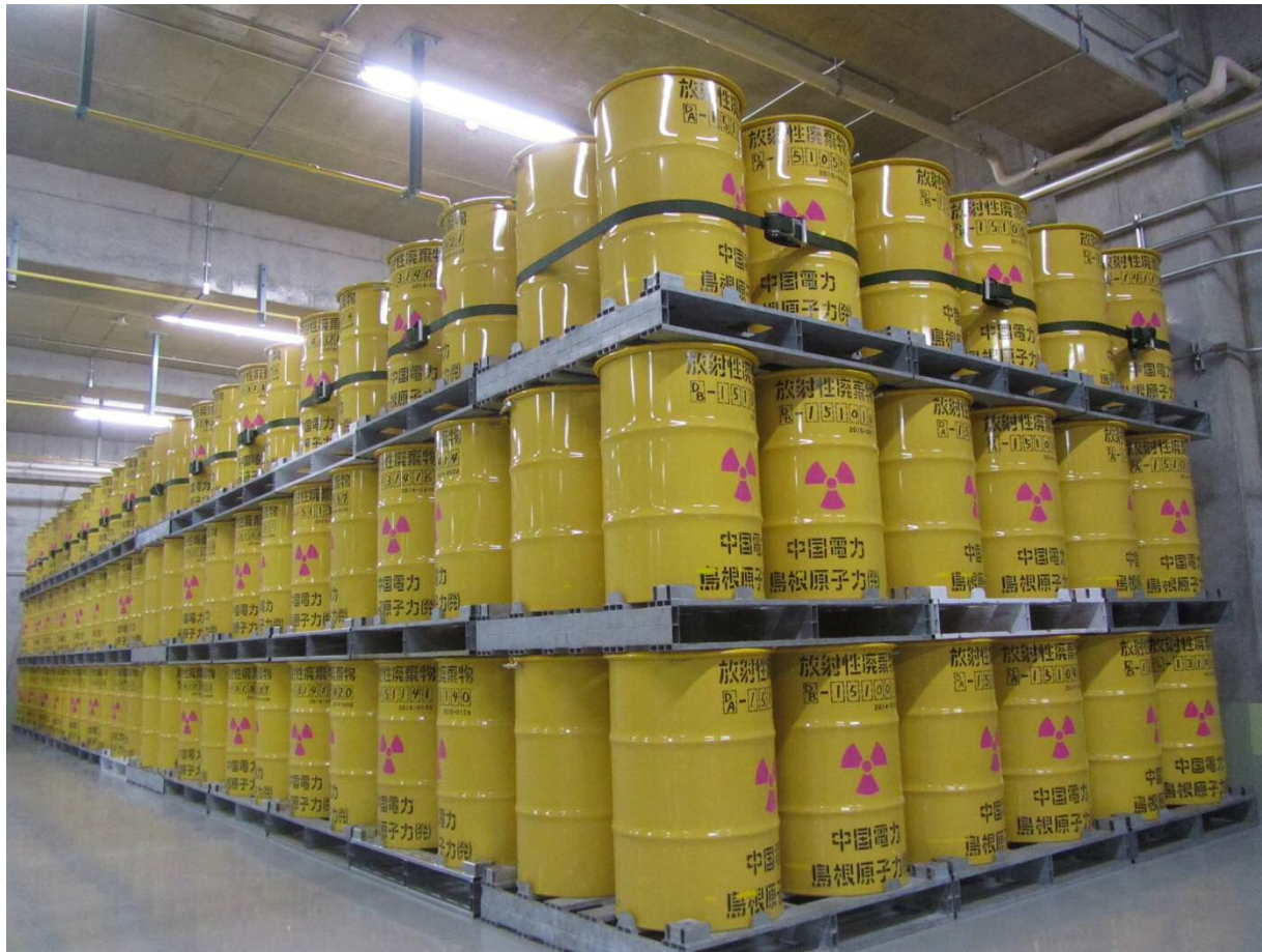
(写真) 固体廃棄物貯蔵所(D棟)での保管の様子
