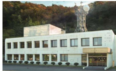
福井県原子力環境監視センター
