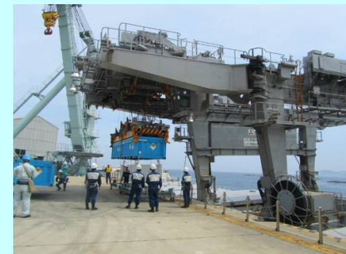
輸送船への吊り込み作業
