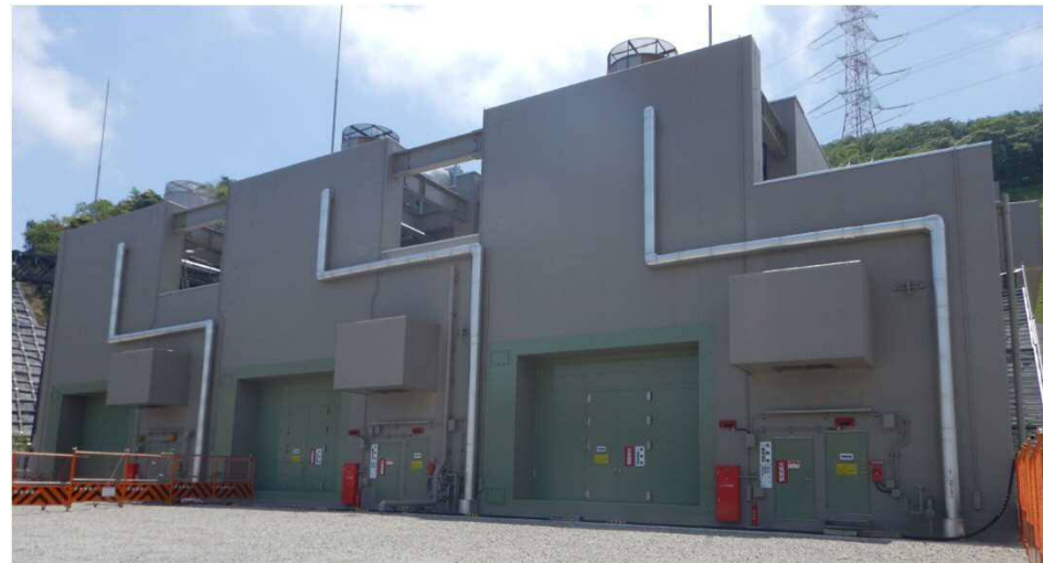
建物工事状況(平成30年5月14日撮影)
