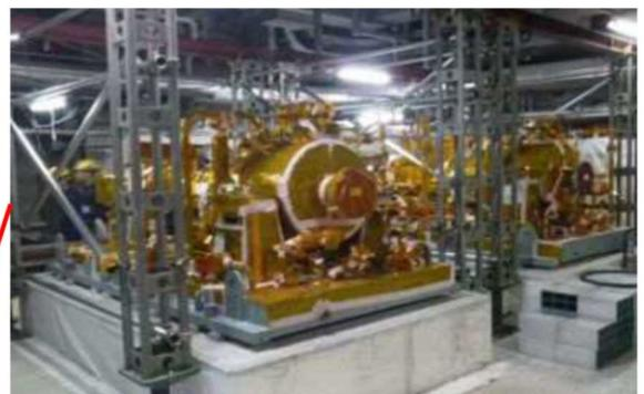
図 5-2-4 残留熱代替除去系
