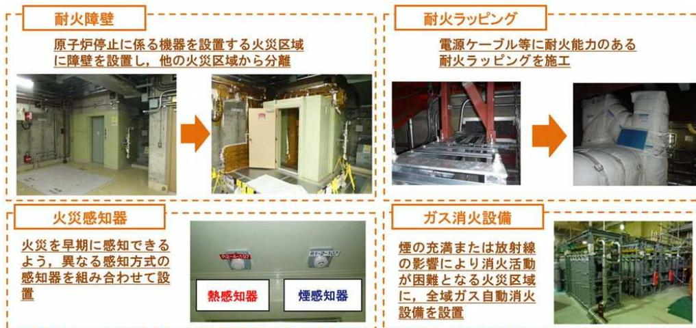
図 5-1-4 火災防護対策の例
