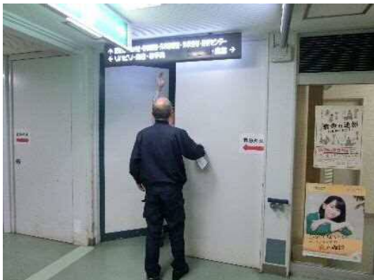
107_防火扉閉鎖作業
