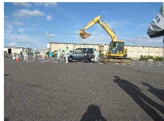
151_道路啓開訓練における放置車両移動
