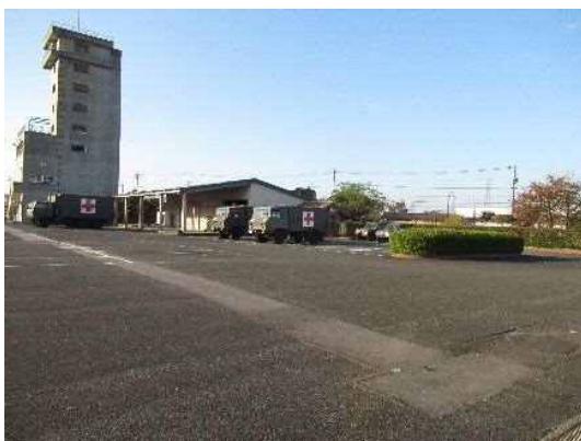
126_消防学校敷地内
