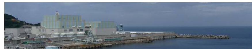
敷地東側からの全景
