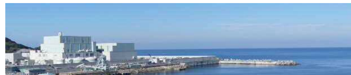
敷地東側からの全景
