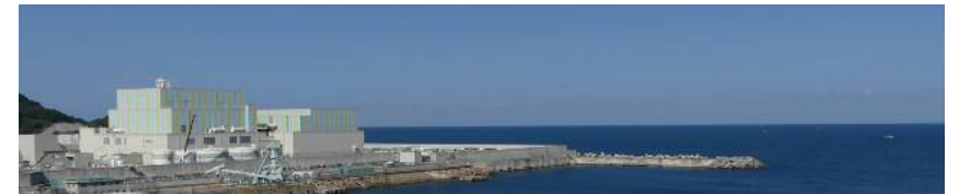
敷地東側からの全景
