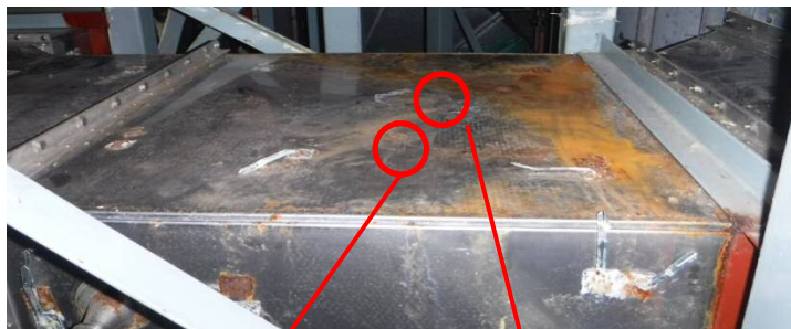
18個の腐食孔の一例
