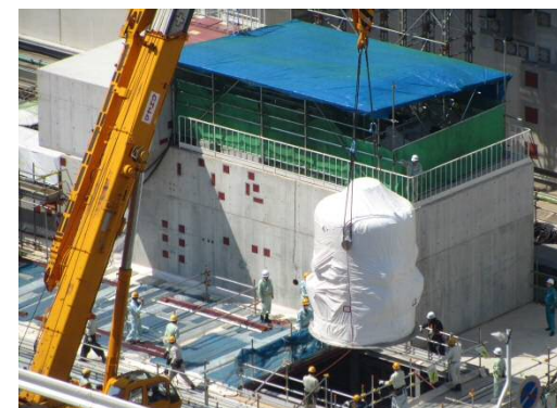
よう素フィルタ装置の吊り込みの様子 (平成27年4月)
