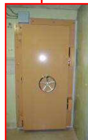
▲ 建物外壁(写真:左)および内部に設置した水密扉
