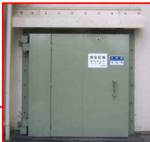
▲ 建物外壁(写真:左)および内部に設置した水密扉
