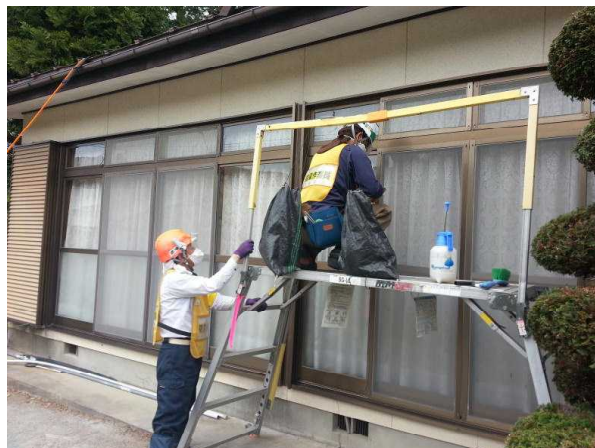
住宅除染作業の状況
