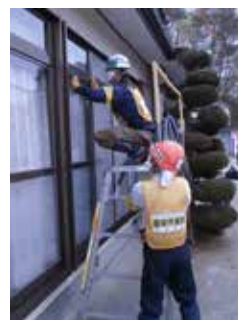
住宅除染作業の状況
