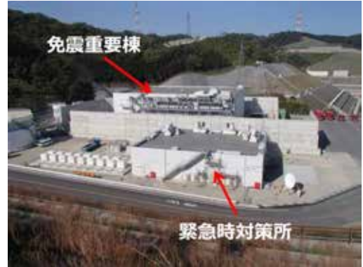
緊急時対策所と免震重要棟
