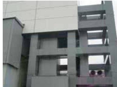
構内バスから見る4号機
